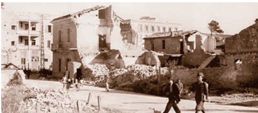
Via Italica, palazzi abbattuti e macerie; sullo sfondo, al centro, si vede lo stabilimento del Pastificio De Cecco. Tratto da: A. Bertillo - D. Franco, Pescara nella bufera, Ed. Associazione Progetto Incontro Montesilvano 2001
